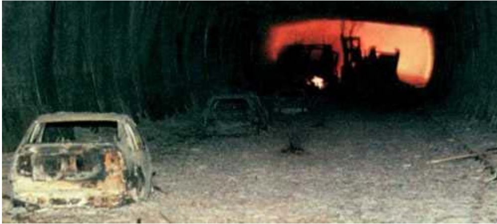
Figura 4. Incendio en el túnel de Tauern
