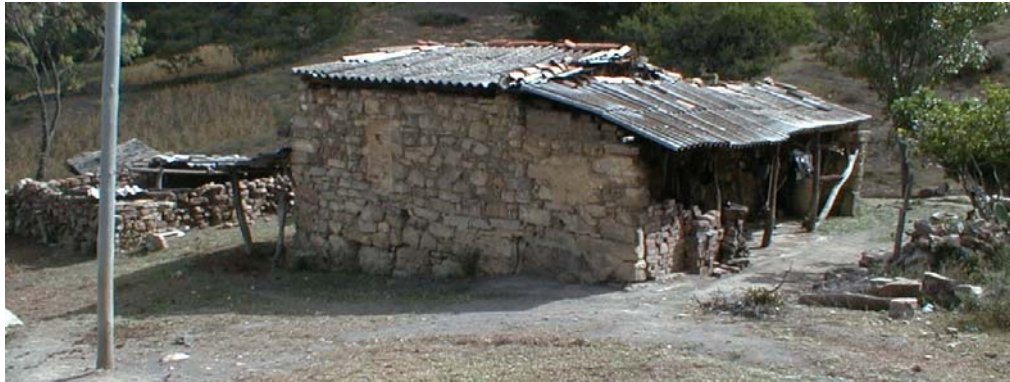
Figura 4: Vivienda en la vereda el Hatillo, municipio de Soata, Boyacá. Sitio de captura de insectos T. dimidiata .
