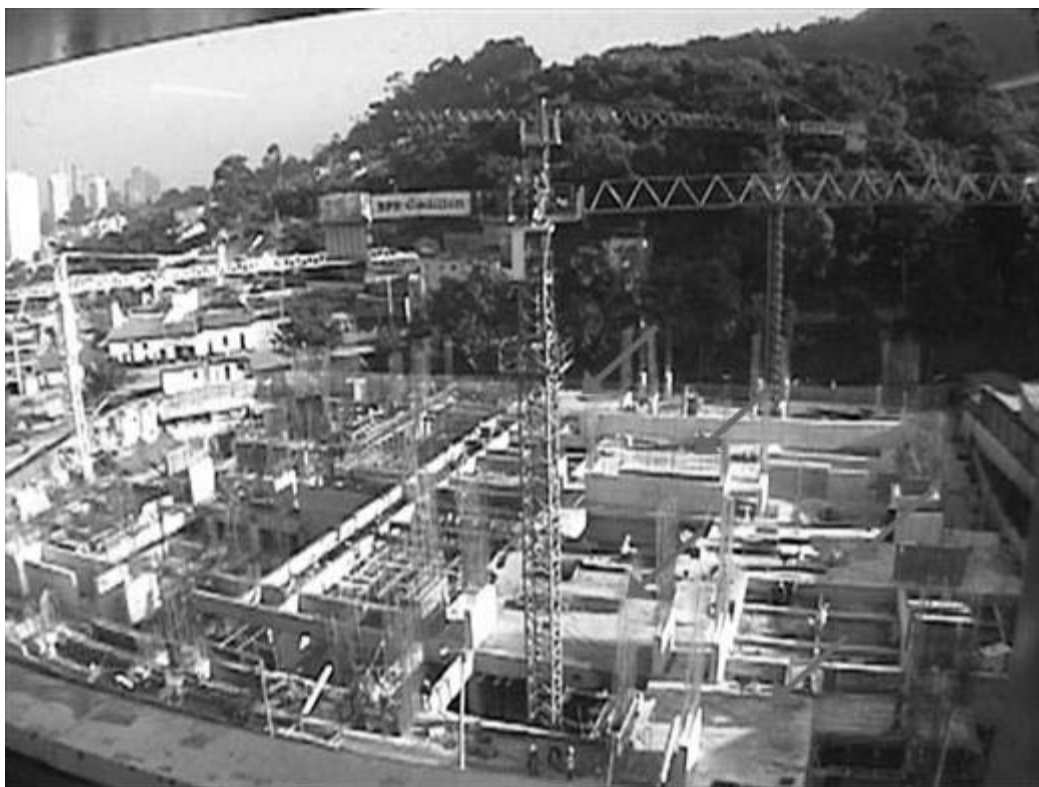
Imagen 21: Ubicación de las losas fundidas.
