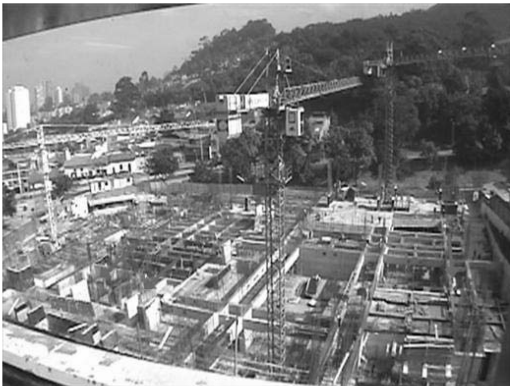
Imagen 22: Ubicación de las vigas principales
