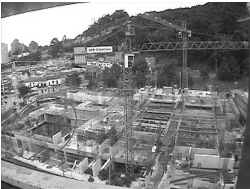
Imagen 25: Ubicación de atrasos en la obra.
