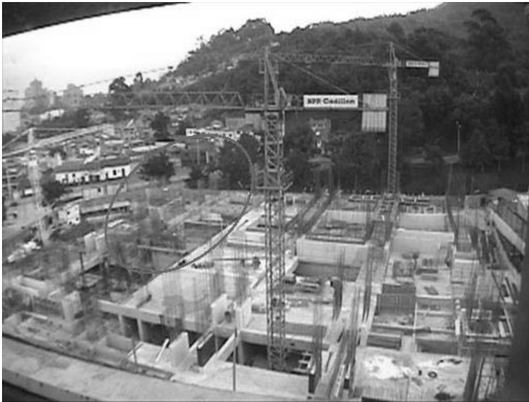
Imagen 24: Ubicación de atrasos en la obra.
