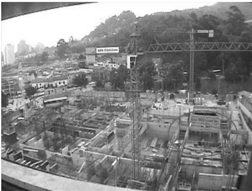
Imagen 26: Ubicación de atrasos en la obra.
