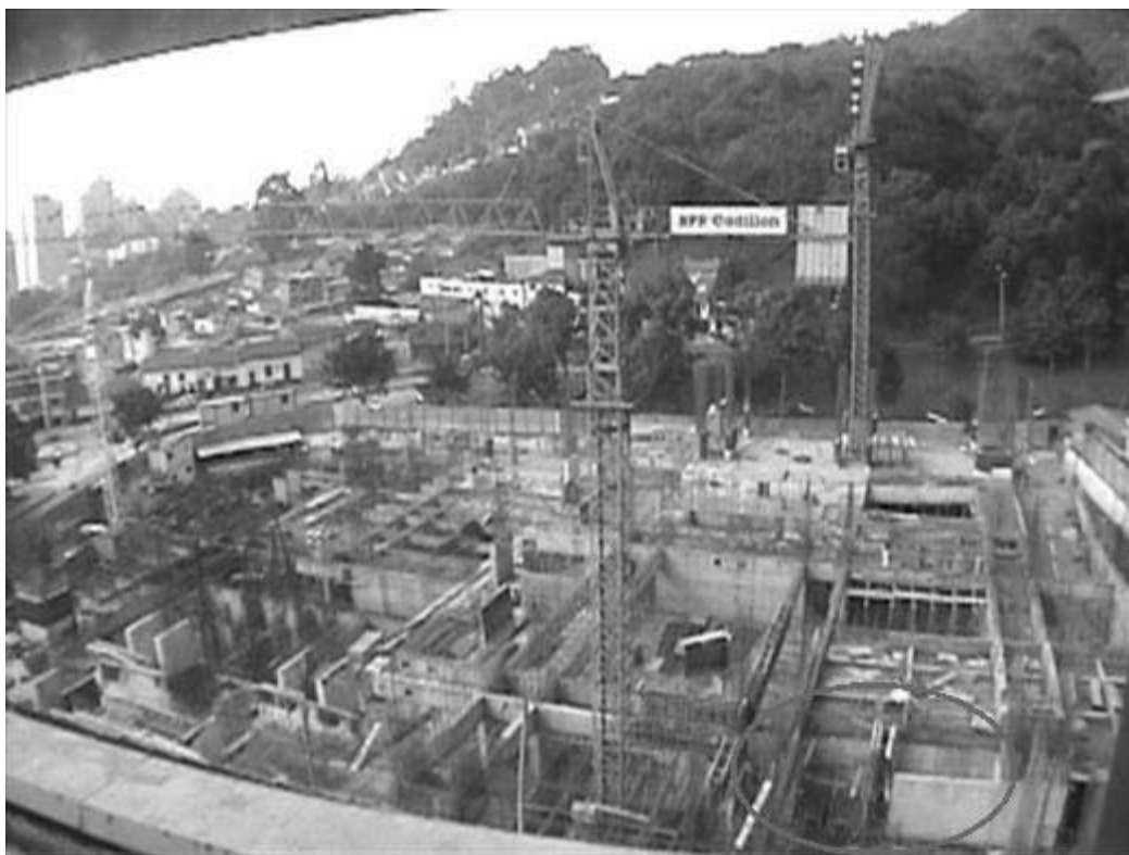
Imagen 23: Ubicación de atrasos en la obra.
