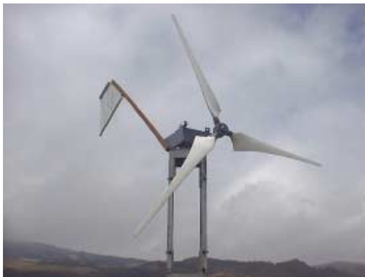
Foto 30. Montaje de la turbina completa en la torre de 2.7 m
