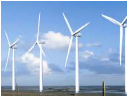
Figura 11. Aerogeneradores de eje horizontal
