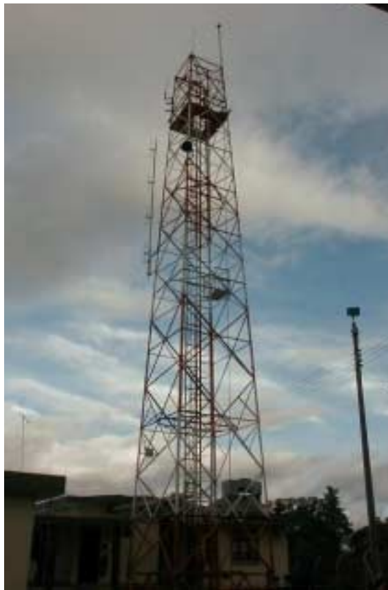
Figura 18. Torre de prueba a 20m y 25 m de altura.
