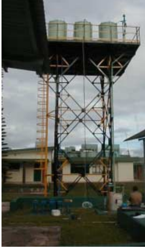
Figura 17. Torre de prueba a 10 m de altura.
