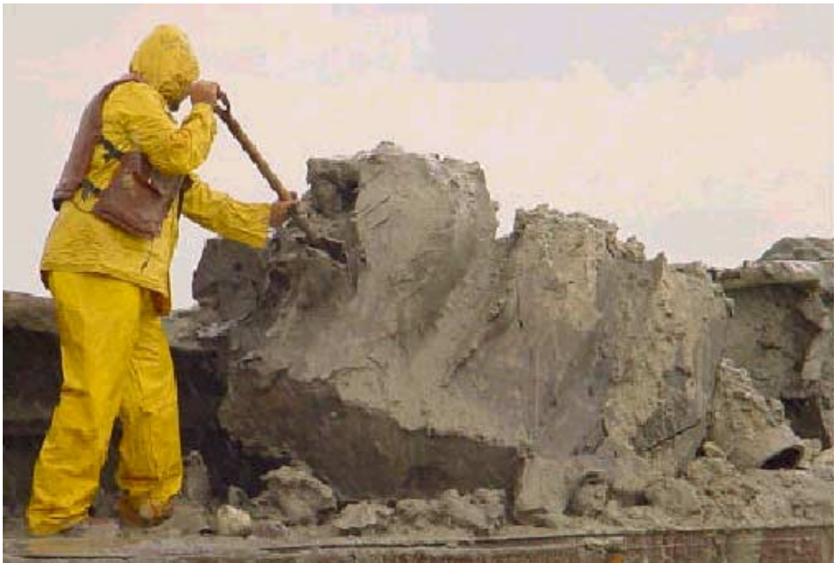
Foto 2.1: Fragmento de arcilla dura producto del dragado, empleado en la construcción de rellenos para la recuperación de tierras en Singapur (Tomada de Phoon et al., 2002).
