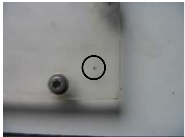
Foto 3.5: Agujero en la tapa de acrílico para permitir la salida del agua.
