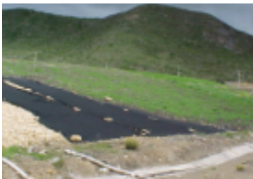
Figura 3. Cobertura de celdas clausuradas en Doña Juana.
