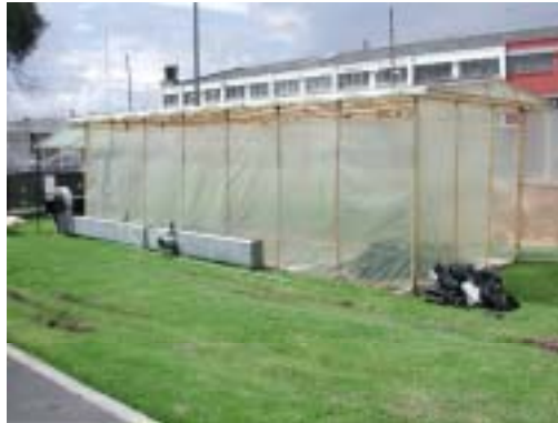
Figura 3. Invernadero para proteger las pilas del ambiente.
