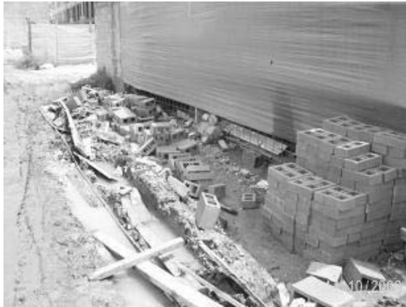
Fotografía 2. Se observa material que podría ser utilizado, pero se está deteriorando por las condiciones de almacenamiento.
