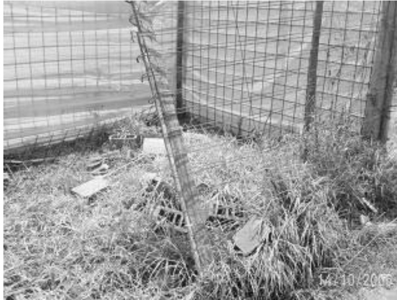
Fotografía 4. Unidades completas de mampostería que se encuentran inadecuadamente almacenadas.
