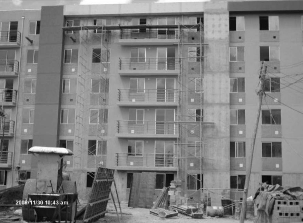
Foto 2. Torre típica del proyecto de construcción terminada en estructura.
