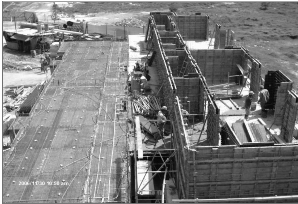
Foto 3. Torre típica del proyecto de construcción en proceso estructura.
