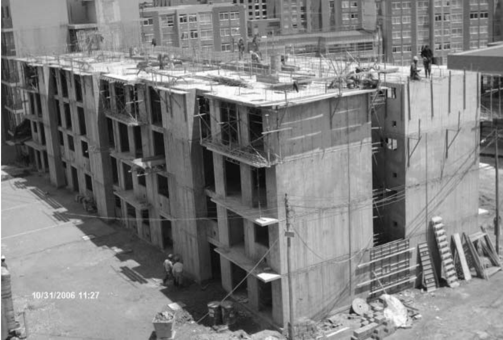
Foto 1. Torre típica del proyecto en construcción.
