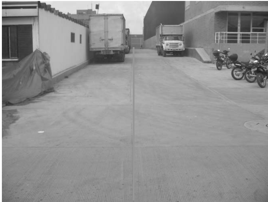
Tramo 3 : Pavimento rígido en buen estado .
